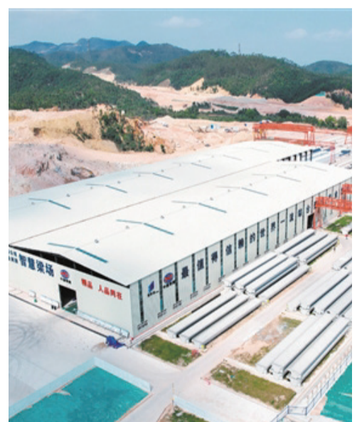
黃茅海跨海通道項目引入BIM技術與智能化技術，打造智慧梁場。
